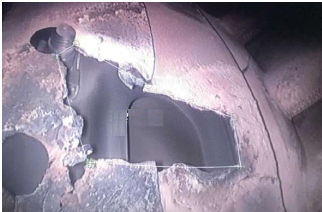
图 5-16 燃烧室的孔探检查
