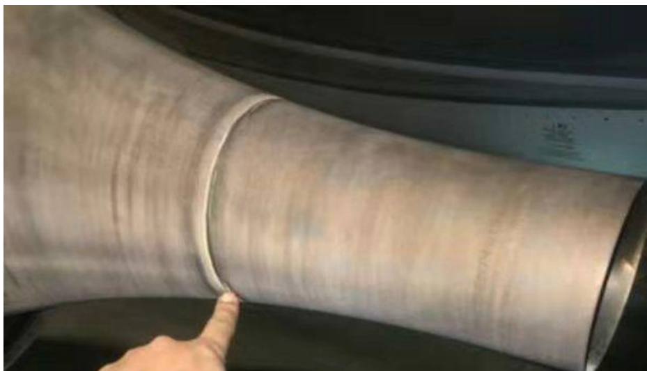
图 7-8 喷管的目视检查
